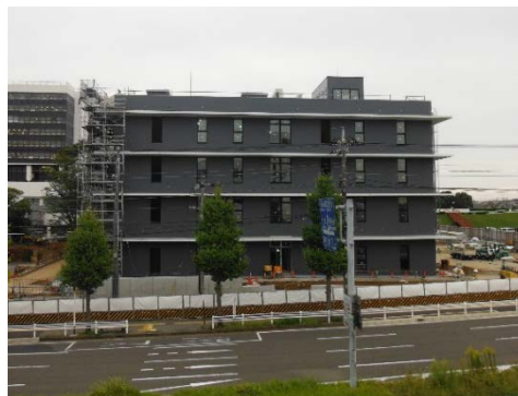
→南面(市道1号線側)からの外観
