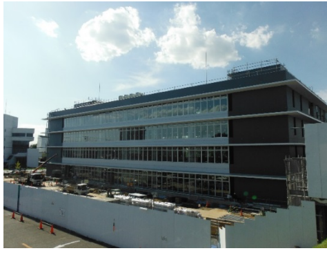
→東面(A駐車場側)からの外観
