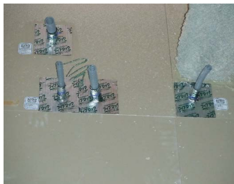
↑防火区画壁の貫通配線周りの区画処理。写真のようなシート状のものやパテ状のものを配管周りに充填するタイプもある。
