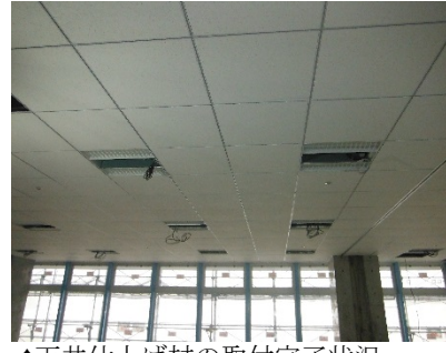
↑天井仕上げ材の取付完了状況。
