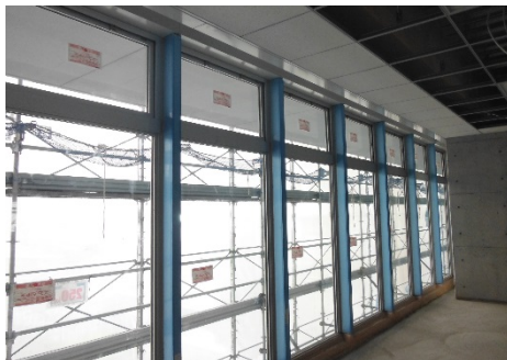
↑上部の小さい窓が排煙窓となっており、火災時に窓が外側に倒れることによって、煙を外に出す構造になっている。
