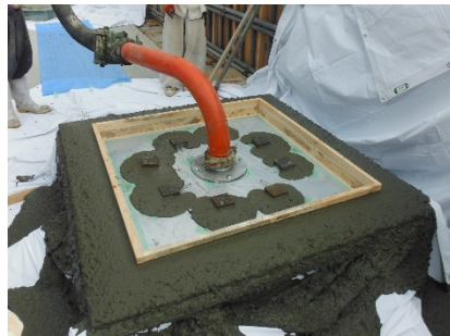
↑高流動コンクリートによる免震基礎打設施工
