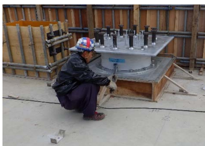
↑トルクレンチによる免震装置ボルト締め状況
