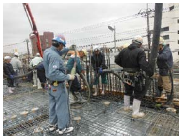
↑コンクリート打設状況 ポンプ車のホースから送られたコンクリートを震動機で締め固めている。
