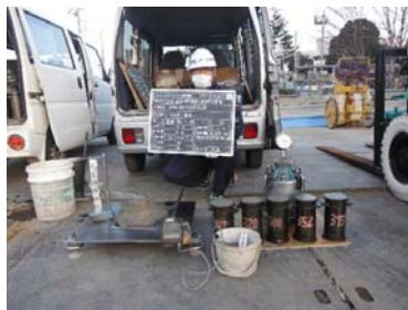
↑コンクリート受入検査状況 スランプ値、空気量、塩化物量、温度の確認及びサンプル採取を行う。
