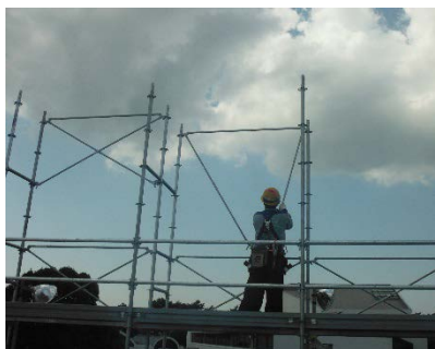
↑先行手摺取付組立状況 安全帯を手摺に掛けながらの作業。
