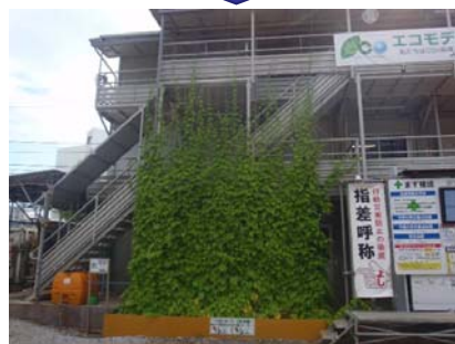
↑ 8月中旬 現場事務所3階まで到達左端にあるオレンジのタンクに雨水を貯水させ、水遣りをしました。
