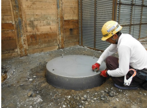
↑FTキャップ取付状況
