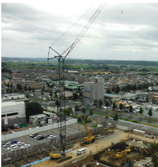
クローラータワークレーン全景(左手前) 市役所屋上より撮影
