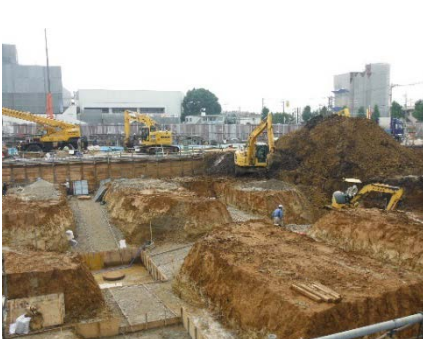
↑バックホー使用しての掘削・搬出状況 それぞれの箇所が高さが異なる
