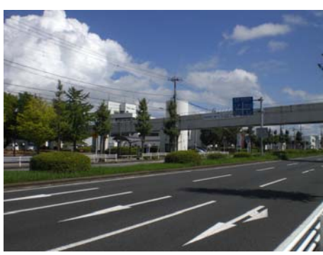
市原市役所と市民会館をつなぐ市道1号線上の連絡橋のありし日の姿
