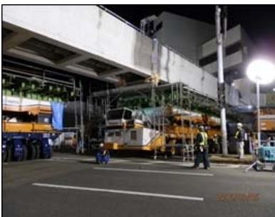
油圧ジャッキが付いた特殊車両で連絡橋を持ち上げて支えている様子
