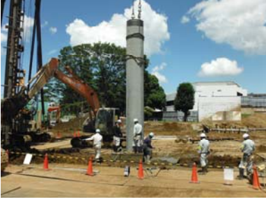
下杭(コンクリート杭)建込み状況
