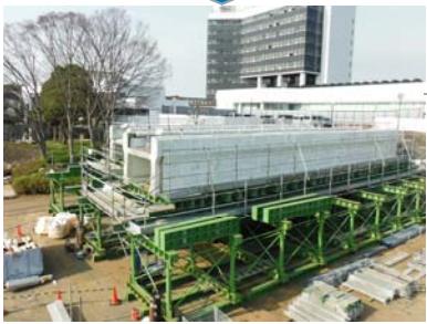
現場場内に運び込まれた連絡橋 この後、さらに小割にして解体しました。
