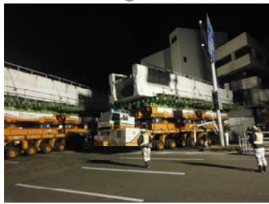
分割された連絡橋をジャッキ付きのトレーラー車両で現場場内に運搬の様子
